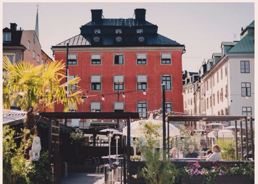
Malmegårds fastighet på Skeppsbron 26 i Stockholm byggdes 1634, men håller i dag nybyggnadskraven när det gäller energieffektivitet. Foto: Jana Eriksson.
